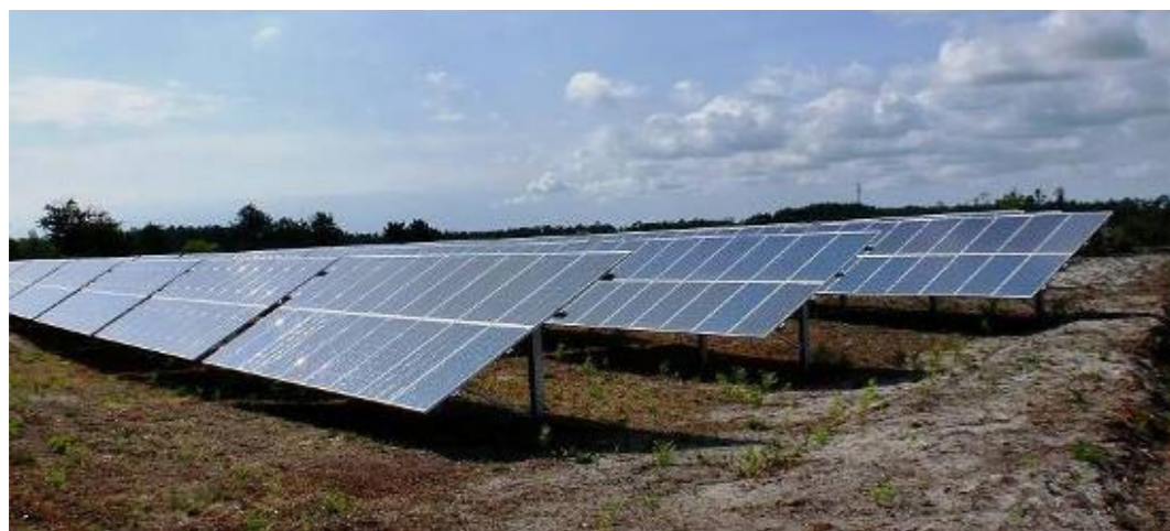
Exemple de centrale photovoltaïque équipée de panneaux fixes – technologie cristalline (couche épaisse)
