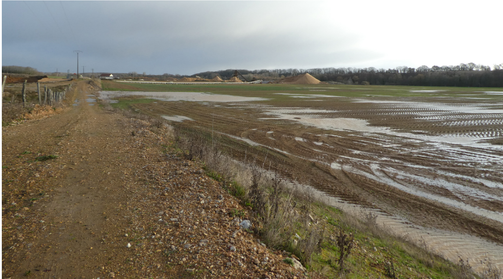
ETAT INITIAL Vue depuis le chemin rural au coeur de l'ancienne carrière
